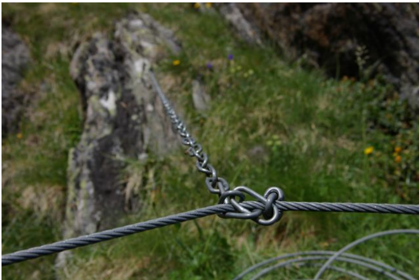
Bild 13 - Stabilisierung des Fixseils.
