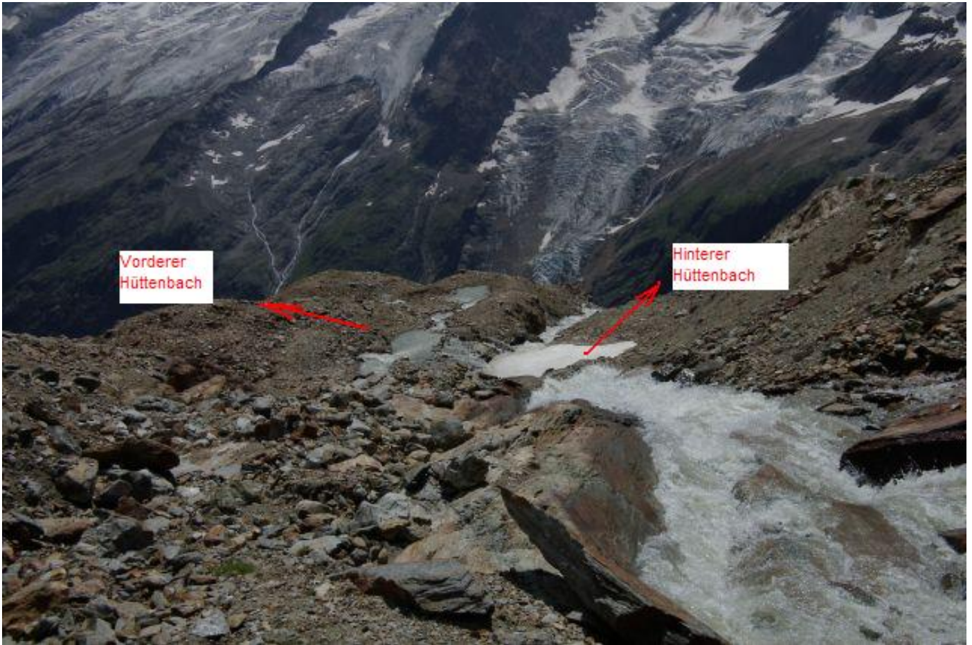
Bild 6 - Hier schießt das Wasser in Richtung der Regulierbecken und Entlastungskanäle, die sich in den vorderen und hinteren Hüttenbach aufteilen.
