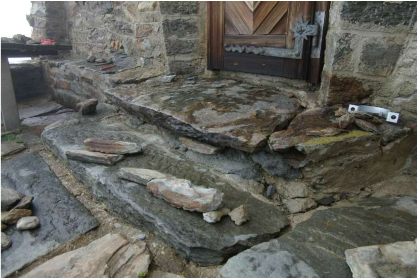
Bild 3 - Erosion auch an der Hütte. Durch kleine Risse dringt Wasser ins Mauerwerk ein. Durch die Ausdehnung des gefrierenden Wassers werden Platten angehoben und Steine gesprengt. Der Schadensverlauf ist dabei exponentiell, d.h. am Anfang lassen sich kleine Schäden relativ einfach beheben. Ohne regelmässige Ausbesserungen werden jedoch umfangreiche Sanierungen unumgänglich.
