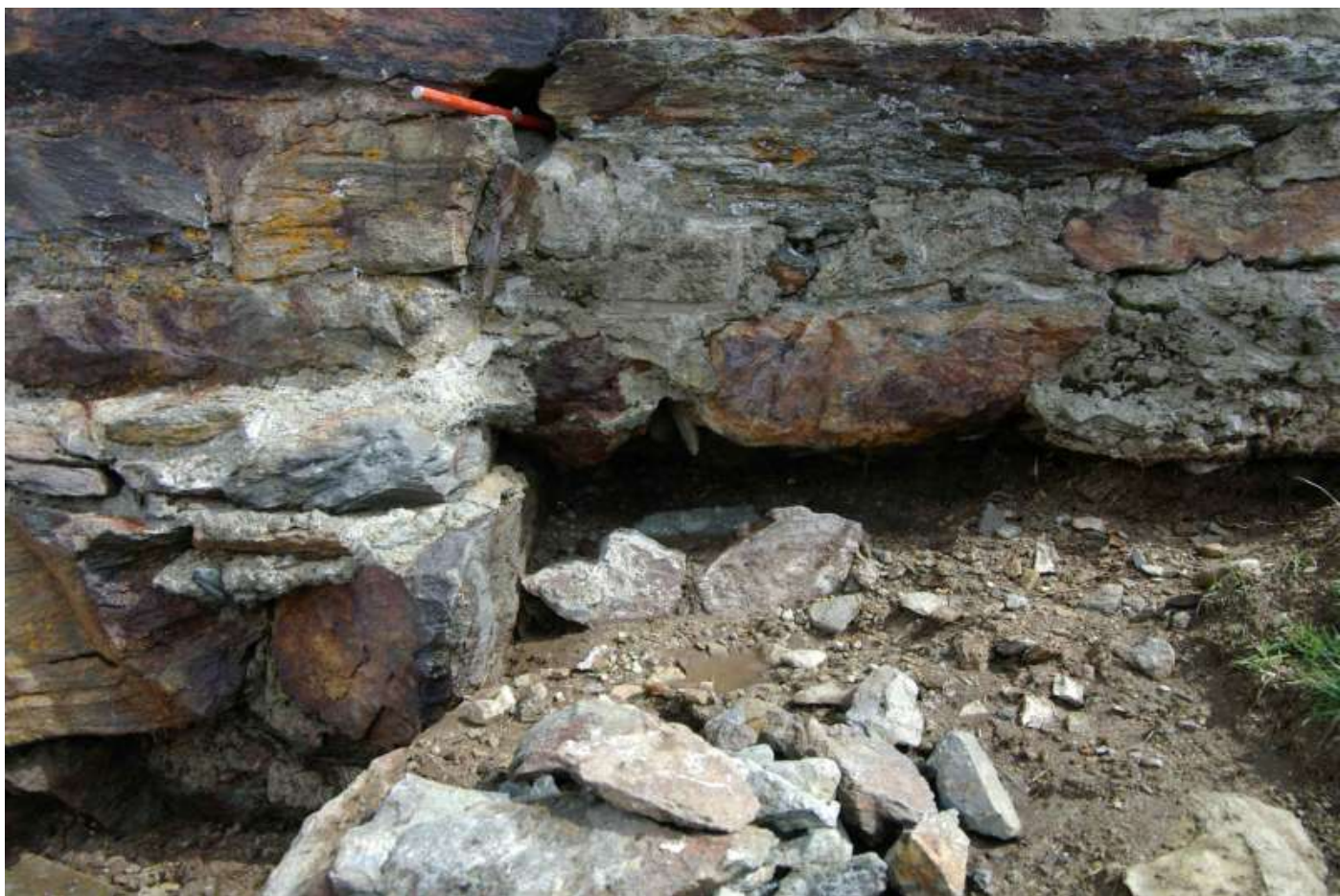
Bild 4 - Diverse Stellen bedürfen einer dringenden Behandlung.
