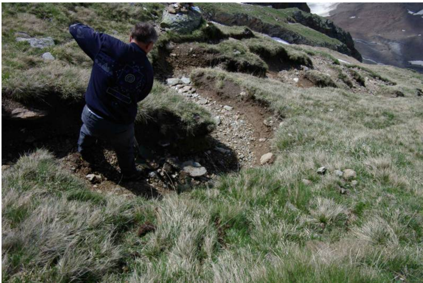
Bild 2 - Roman beim Wegbau: Tiefe Gräben entstehen dort wo sich das Wasser in einer Rinne sammelt und das lockere Material ausschwemmt. Die in Serpentin angelegten Wege ermöglichen das Entwässern bei jeder Kehre. Wo immer möglich, sollte der Weg über Steine und Felsen führen, damit die empfindlichen Grasnarben nicht beschädigt werden.
