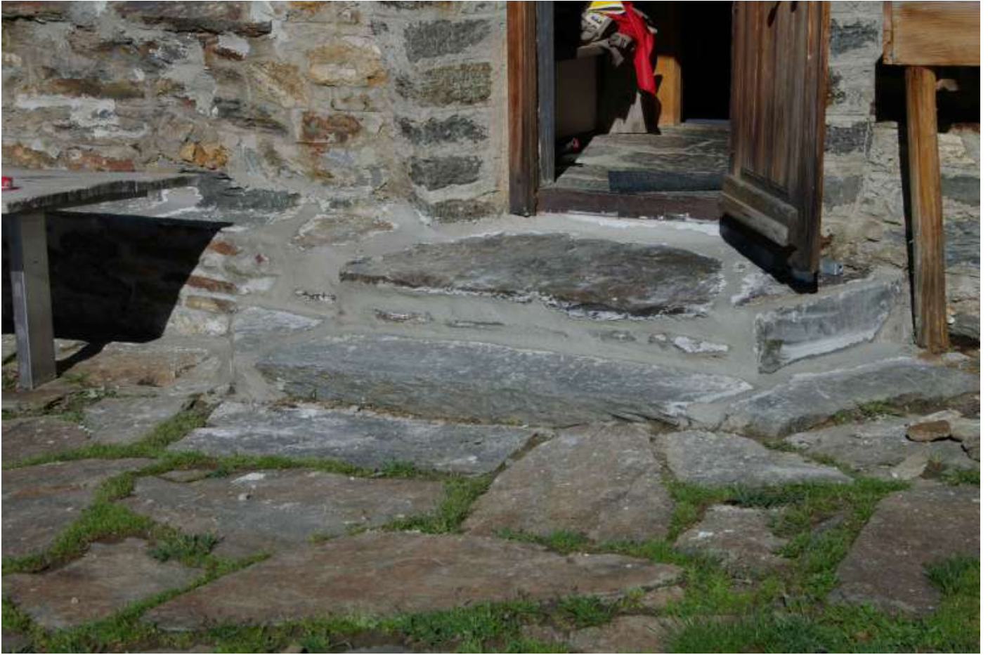
Bild 5 - Während des Dienstes wurden ca. 600 kg Beton und 400 kg Mörtel (Trockenmasse) verarbeitet und die wichtigsten Stellen ausgebessert.
