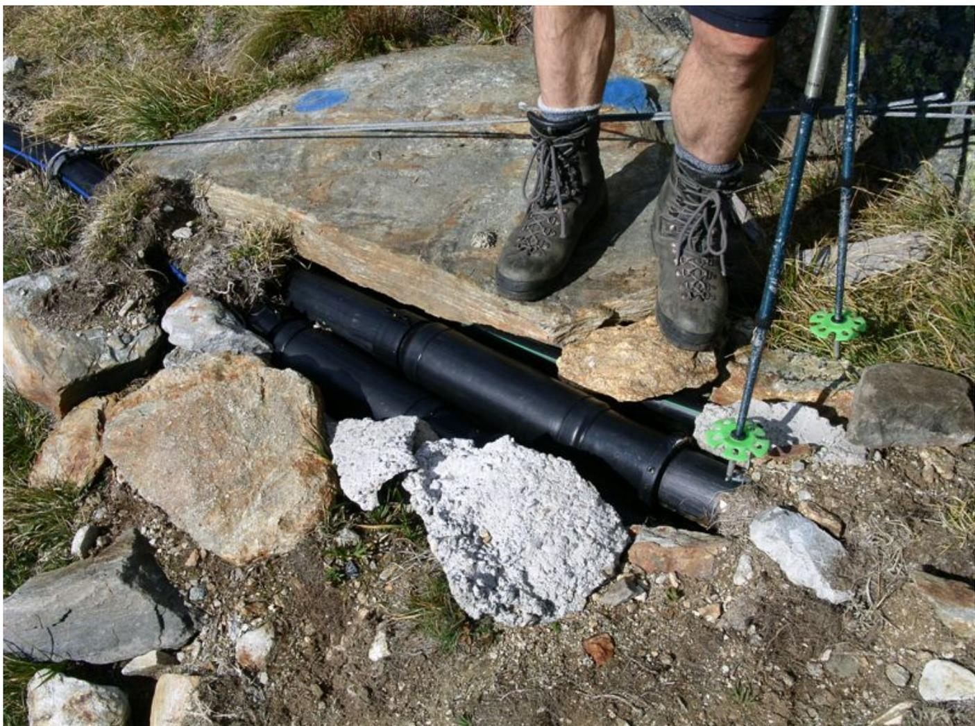
Bild 16 - Das Gewicht reißt an den Muffen
