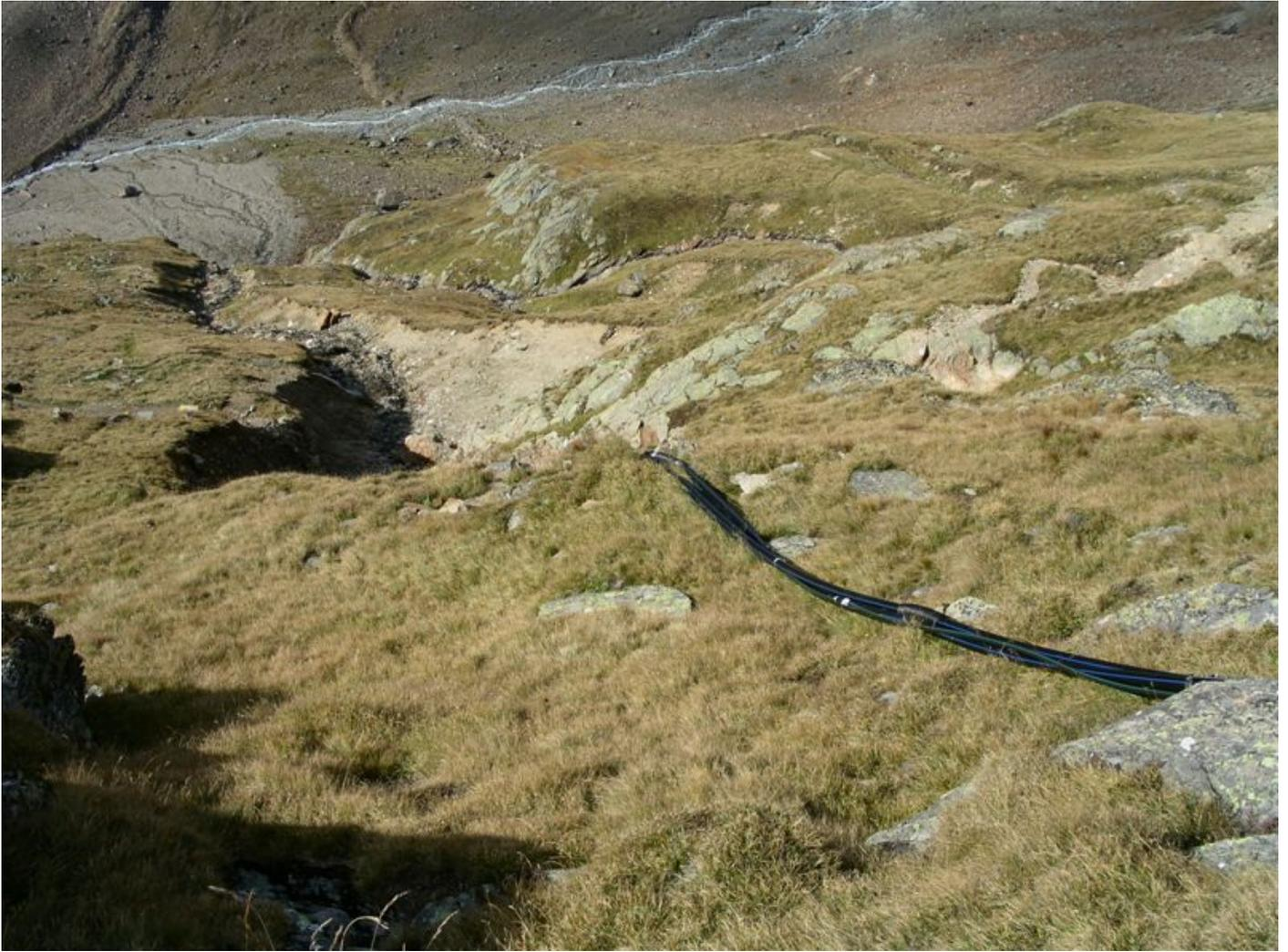
Bild 13 - Die neue Leitung für die Stromversorgung, exponiert
