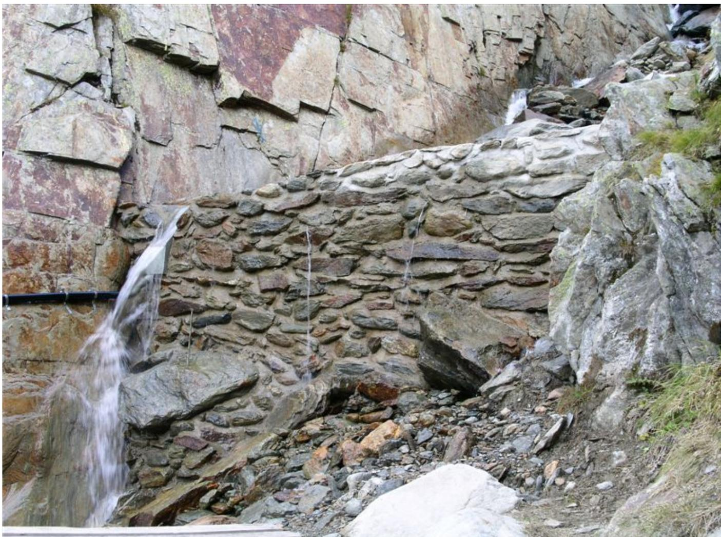
Bild 11 - Ein Versicherungsfall: neue Staumauer und Trinkwasserfassung
