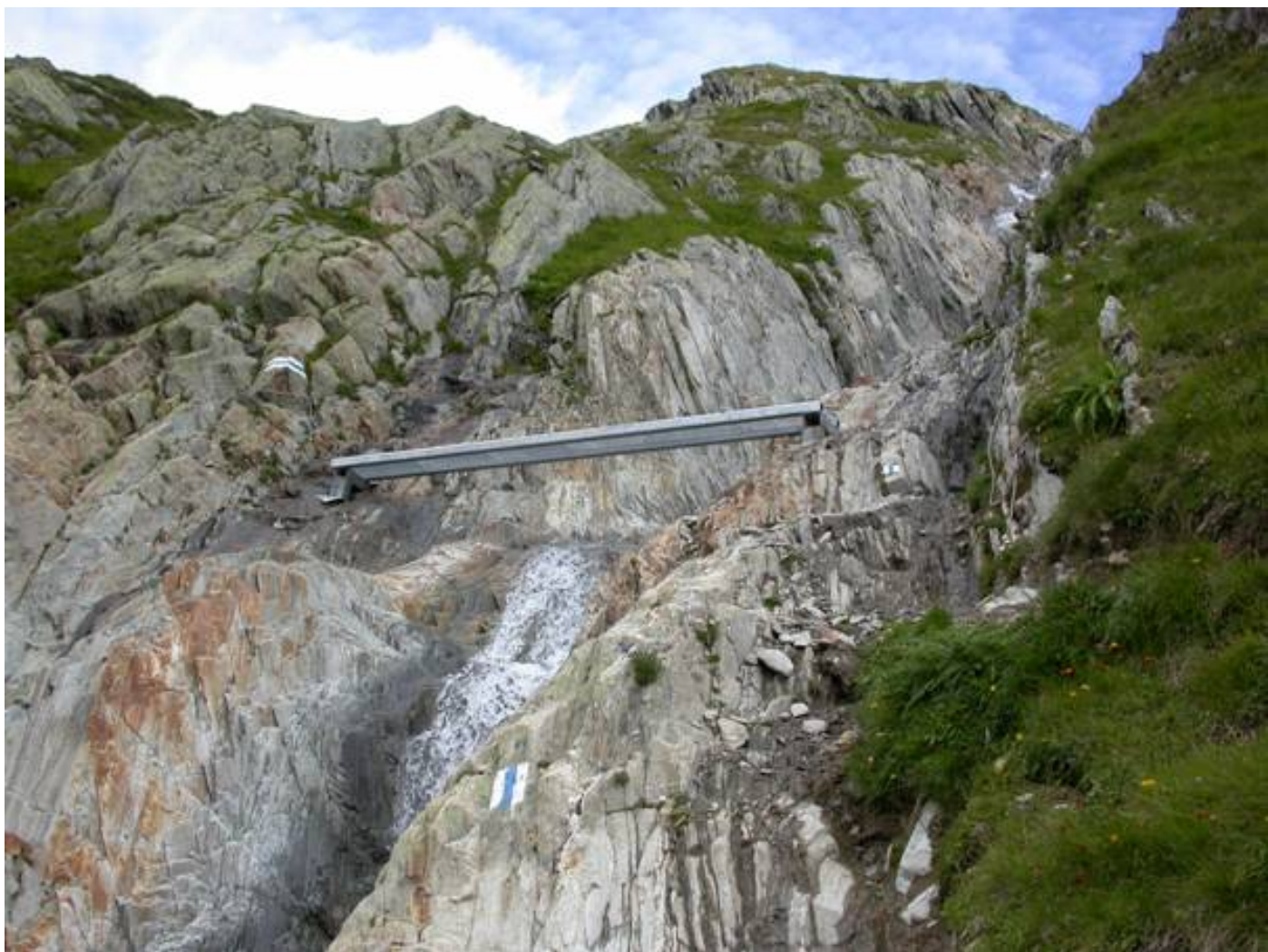
Bild 10 - Die neue Brücke von unten.
